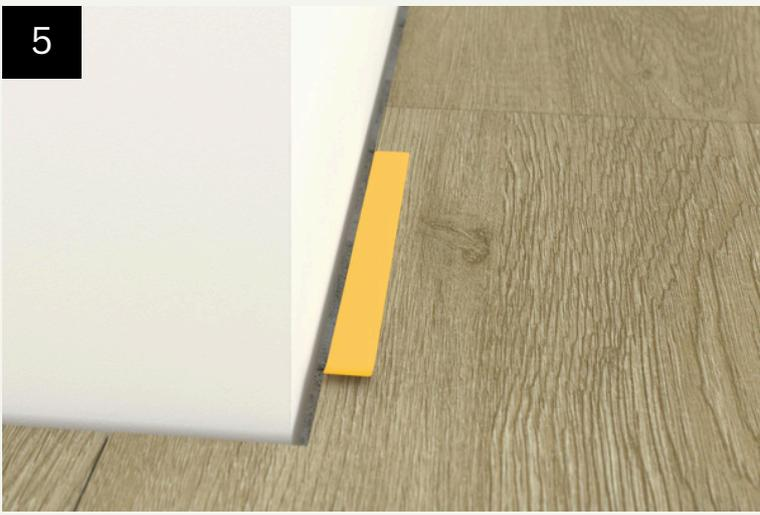
Die einzelnen Klebestripes werden vom Klebebogen abgezogen (Abzuglasche beachten) und zur langen Seite hin bündig mit der Kante der Anschlussfuge auf den Bodenbelag geklebt.
