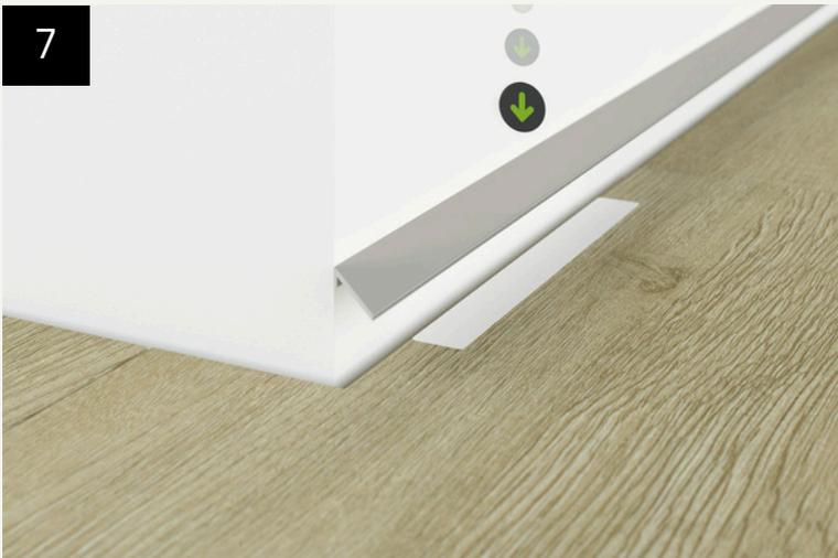
Nun kann das Abschlussprofil der Wand entlang geführt und einfach auf die Klebestripes aufgeklebt werden. Die korrekte Positionierung ist wichtig, da nach dem ersten Klebestripe die Leiste nicht mehr parallel zur Wand verschoben werden kann.
